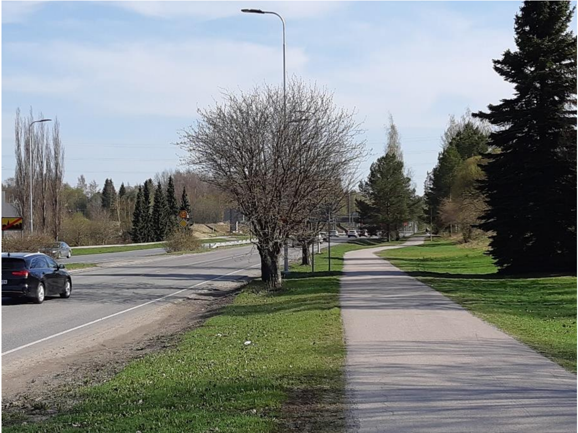
Kuva 25. Hervannan valtaväylän varressa kasvaa jo nykyisin monipuolista suoja- puustoa. Väylän ylitse suunniteltavat uudet sillat ja kasvillisuusalueiden tilallisuuden kehittäminen lisäävät ympäristön kaupunkimaisuutta ja korkealaatuisuutta.
